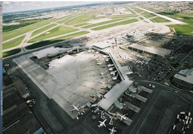
Système de distribution de carburant aéroportuaire - Montréal
