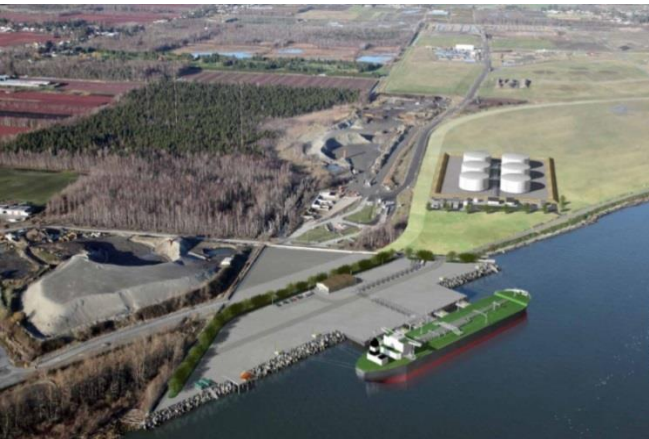
Terminal portuaire avec pipeline (en cours) - Vancouver
